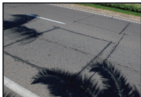
固定壓線照相系統
